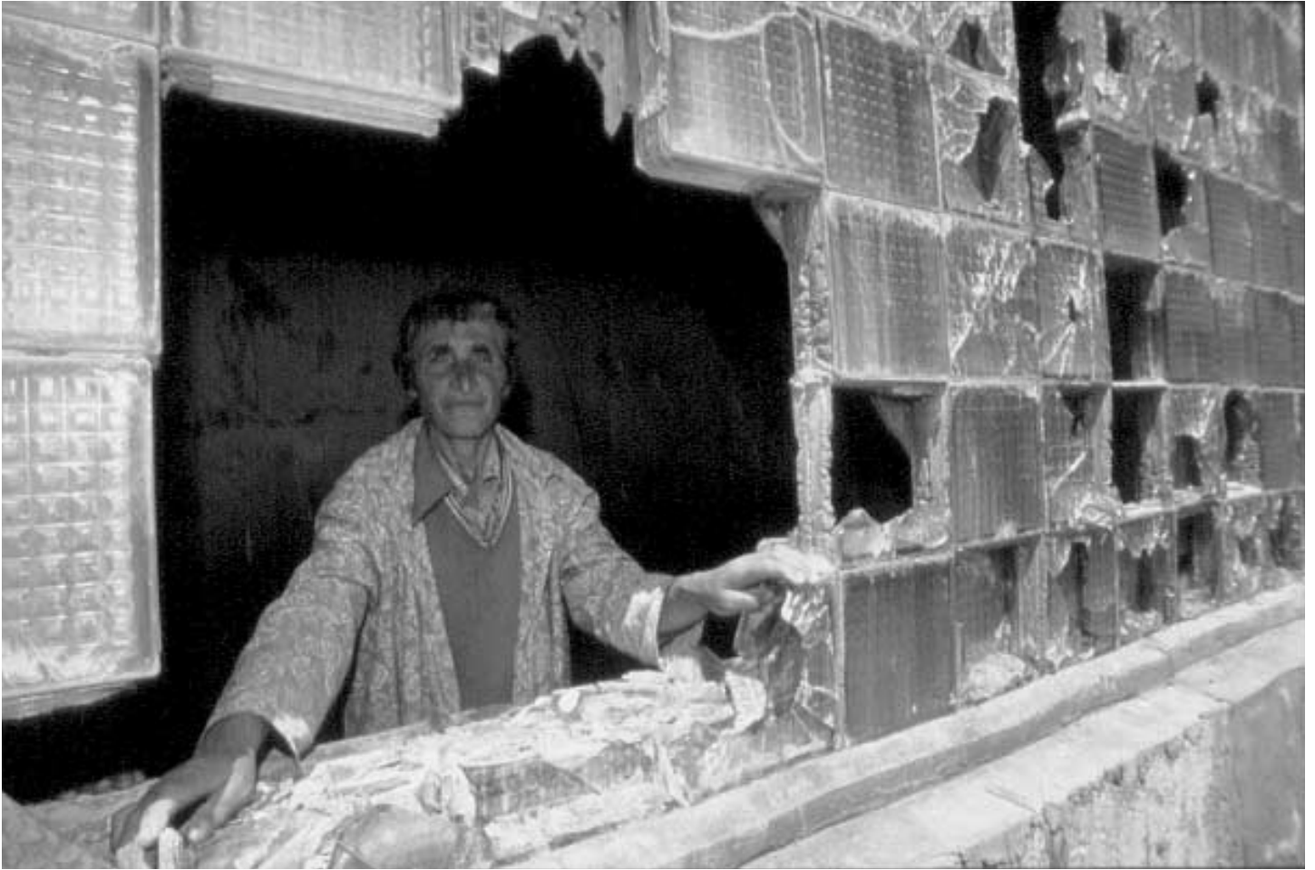
Das heruntergekommene psychiatrische Krankenhaus in der armenischen Stadt Vardenis wurde jetzt gründlich renoviert und modernisiert. Foto: Roger Job
