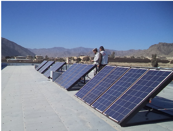
Neu errichtete Solarmodule in Nadir Shah Kot, Provinz Chost
