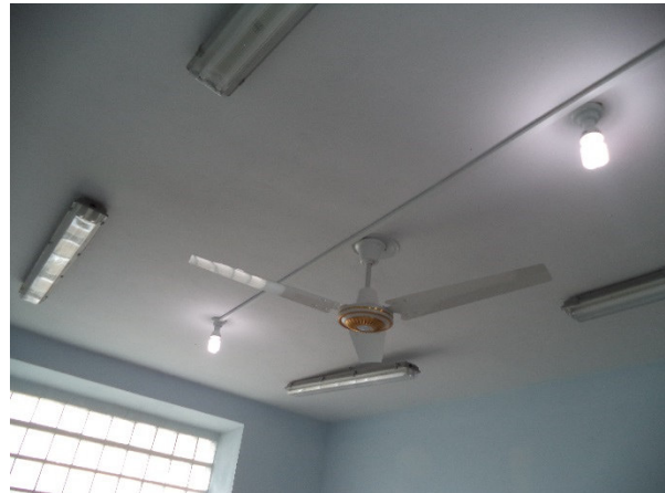
Solarstromversorgung in Tani, Provinz Chost
