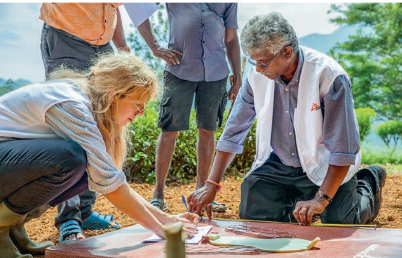
Unsere Wasser- und Sanitätsexpertin und unser Logistiker markieren Standorte für den Bau von Latrinen und Duschen.
