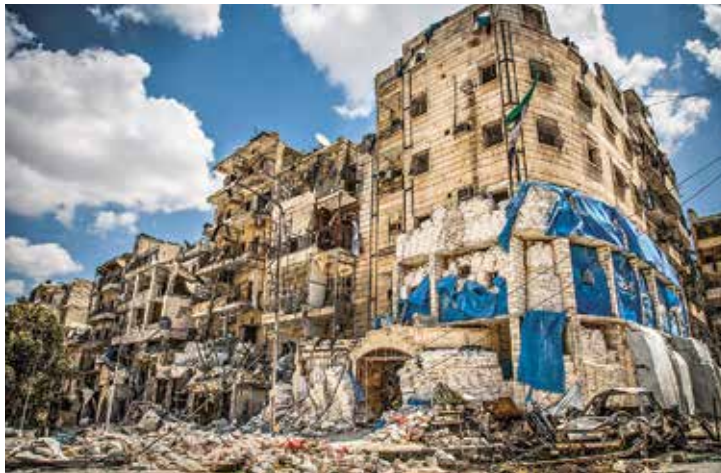
SYRIEN: Beim Angriff auf dieses Krankenhaus in Ost-Aleppo kam ein Arzt ums Leben. Das Gebäude wurde notdürftig mit Sandsäcken repariert. © Karam Almasri
